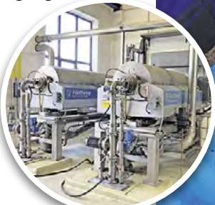
▲ Wie hier auf der Kläranlage Gera des ZVME wird Klärschlamm mithilfe von Zentrifugen entwässert.
