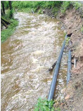
Kostenintensiv: Viele Versorgungsleitungen wurden freigespült.
