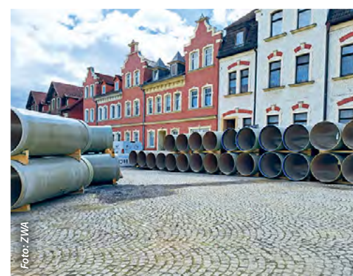
Aus Alt mach Neu: Für den Hauptsammler H werden in der Alten Freiheit neue Abwasserrohre verlegt.
