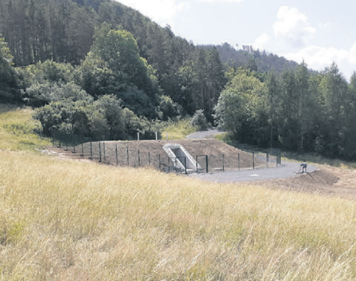
Der neue Hochbehälter speichert das Trinkwasser für Oberloquitz.
