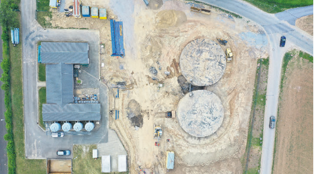
Aus der Vogelperspektive sind die beiden runden Wasserspeicher gut zu erkennen. Das Fassungsvermögen: Jeweils 1000 m3. Bald kann die Betondecke aufgesetzt werden.
