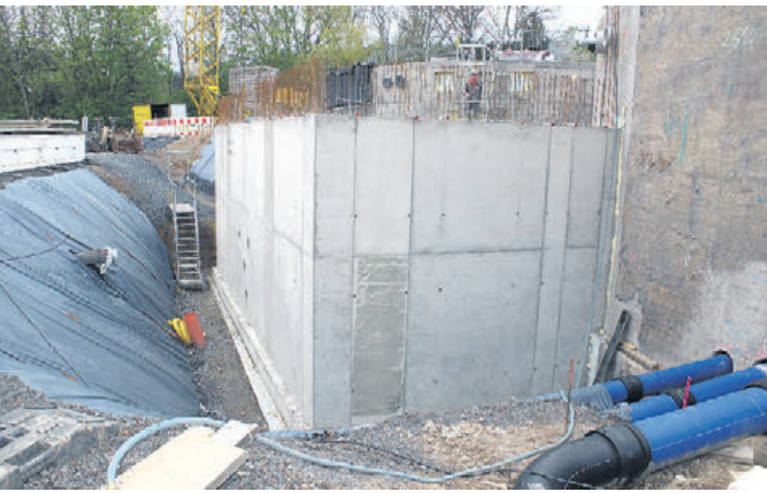
Viel Beton: Die neue Schieberkammer, in der die Mischung des Wassers künftig stattfindet. Hinter den Wänden wird bald viel Technik sein.
