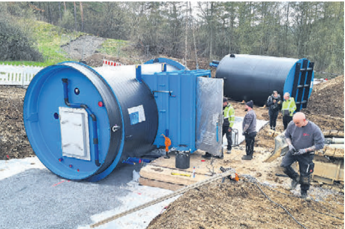
Montage des neuen Hochbehälters Oberloquitz.
