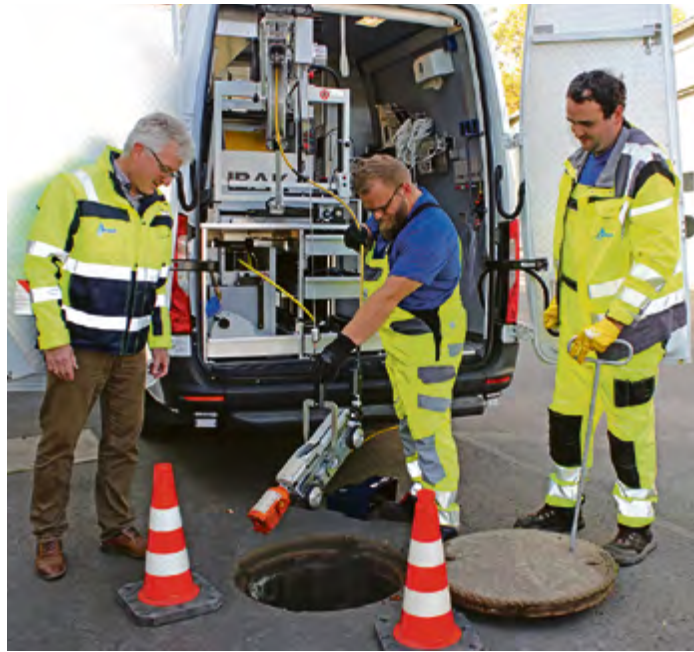
Per TV-Kanalinspektion wird der Zustand der Rohre überprüft: Pro Tag können bis zu 1.000 Meter gefilmt und begutachtet werden.
